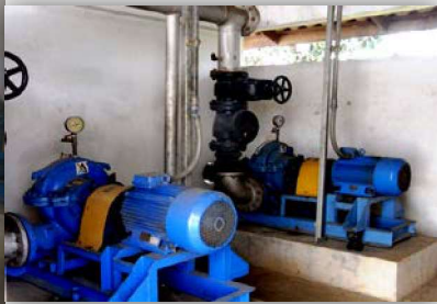
เครื่องสูบน้ำดิบ(Raw water pump) ขนาด 25 แรงม้า ปริมาณการไหล 250 ลบ.ม./ชม.ท่อ 8x6x12 เครื่องทำงานวันละประมาณ 18 ชม. (สลับการทำงาน)
