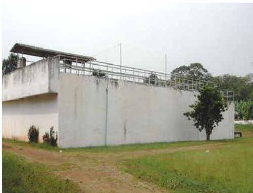
อาคารโรงกรองน้ำ (หลังที่ 2) เป็นถัง คสล.ประกอบด้วย 4 ส่วน ดังนี้
