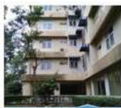
พื้นที่ติดตั้งระบบ
