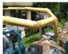
การเดินท่อน้ำเสีย
